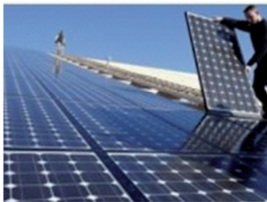
Figura nr. 4 Panou solar fotovoltaic
